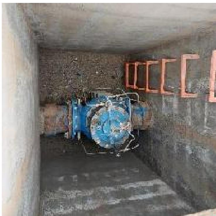
Fotografía 04-Válvula Hidráulica
