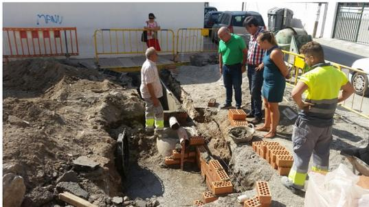
El Ayuntamiento de Adra ha ejecutado nuevas obras para mejorar y agilizar el drenaje de aguas pluviales en el entorno del CEIP Mare Nostrum y el Bulevar de Poniente, mediante la creación de dos nuevos pozos filtro y varios imbornales para favorecer la recogida de pluviales, disminuyendo así las molestias que ocasionan las lluvias a los vecinos de la zona.
